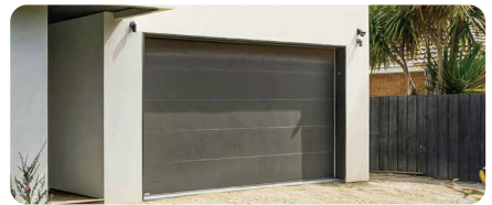
Garage Door Control
